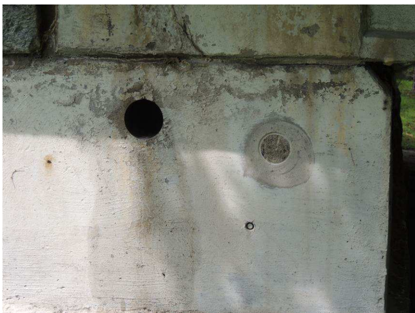
Zkušební místo pro stanovení soudržnosti betonu odtrhovým přístrojem úložného prahu levé opěry a místo odběru vzorku pro destruktivní anovení pevnosti betonu
