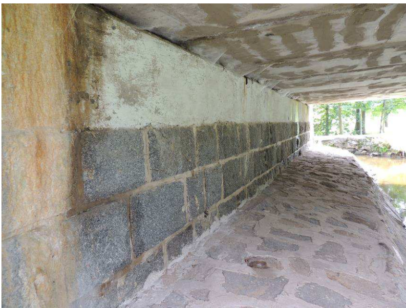
Pohled na pravou opěru – dochází k zatékání mezi KA nosníky a závěrnou zídku
