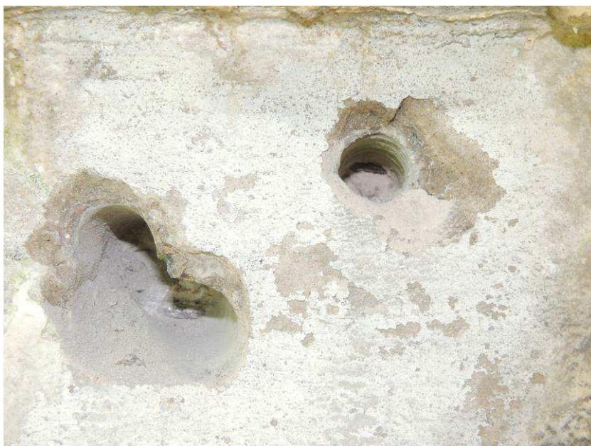
Sonda k předpínací výztuži nosníku N1 z boku
