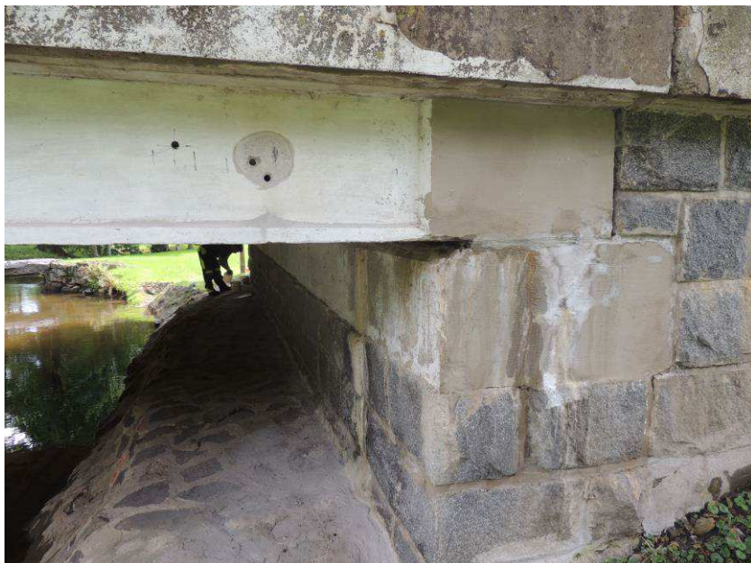
Stopy po zatékání mezi závěrnou zídkou a KA nosníky nad levou opěrou
