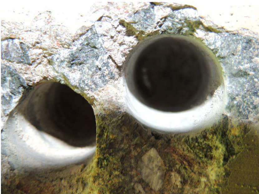
Sonda k předpínací výztuži nosníku N2 ze spodního líce
