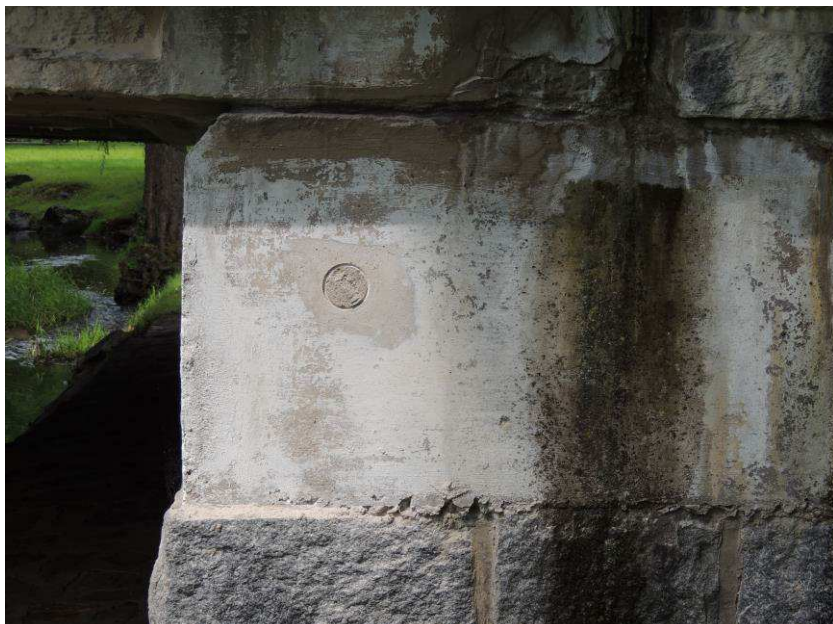
Zkušební místo pro stanovení soudržnosti betonu odtrhovým přístrojem úložného prahu pravé opěry
