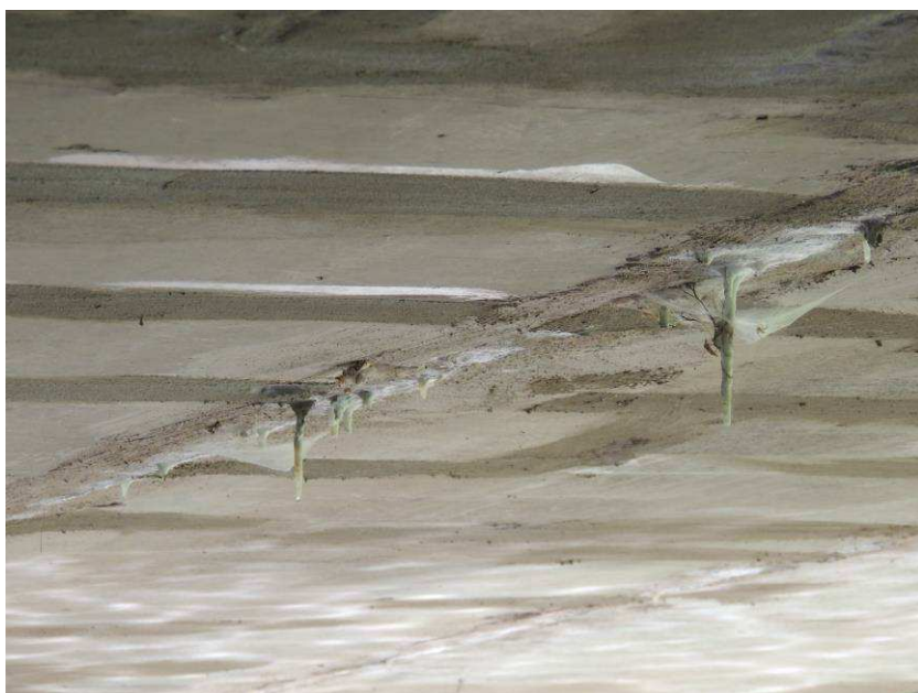
Vápenné inkrustace na spárách mezi nosníky
