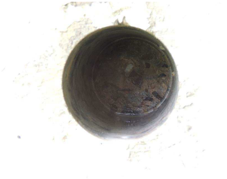
Pohled do otvoru po odběru vzorku betonu pro stanovení pevnosti
