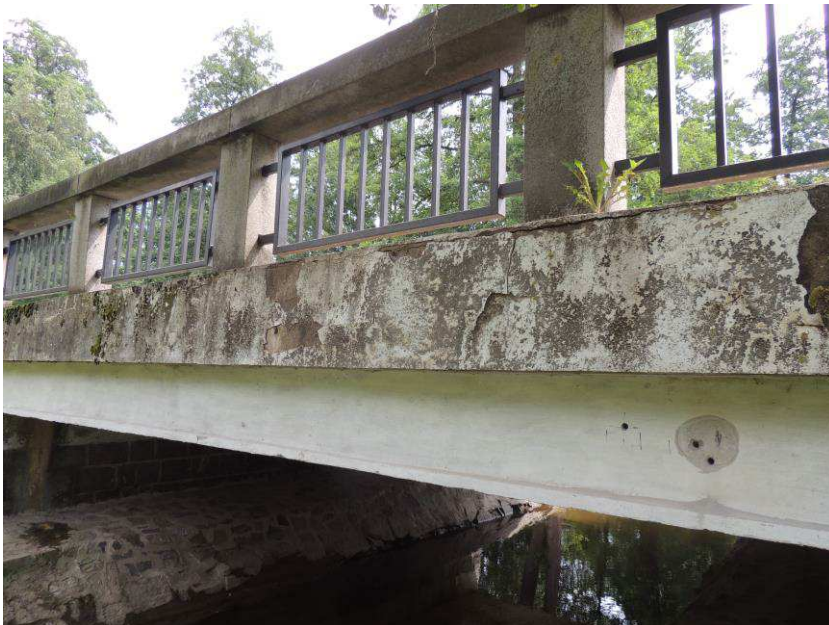
Degradace betonu řimsy nad výtokovou stranou mostu
