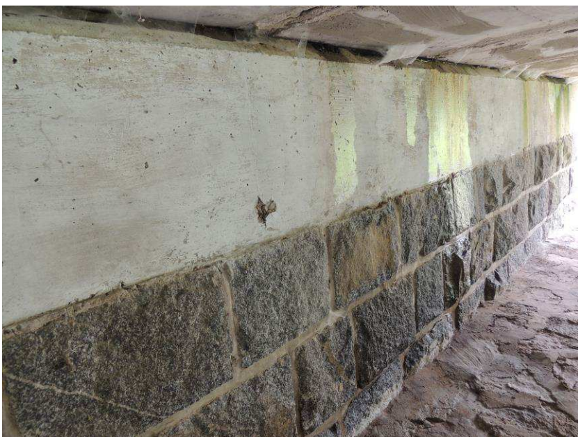
Stopy po zatékání mezi závěrnou zídkou a KA nosníky nad pravou opěrou
