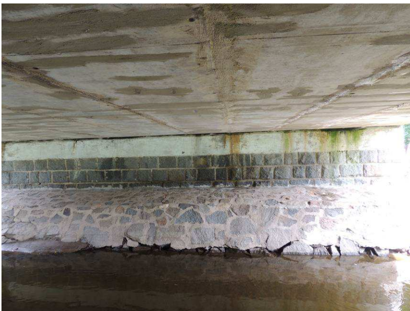
Vypadané spárování opevnění dna kyklopským zdivem
