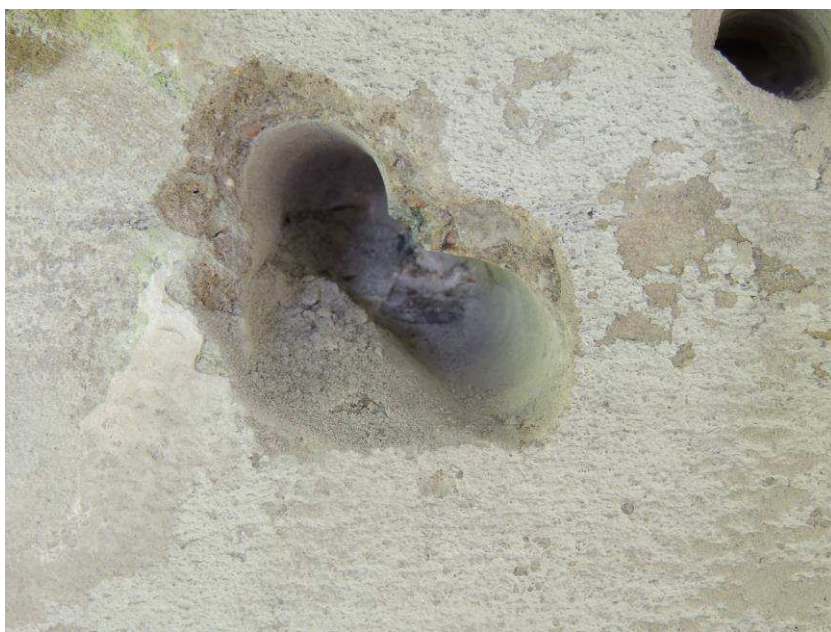
Sonda k předpínací výztuži nosníku N1 z boku
