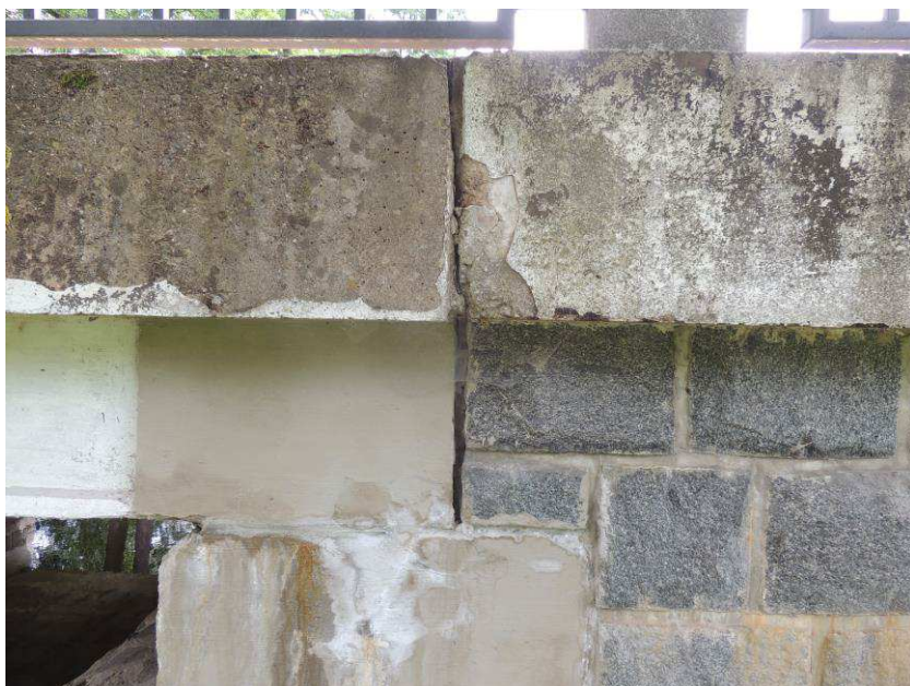
Detail mezery mezi závěrnou zídkou a KA nosníky nad levou opěrou
