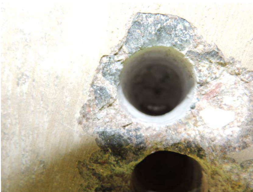
Sonda k předpínací výztuži nosníku N10 ze spodního líce
