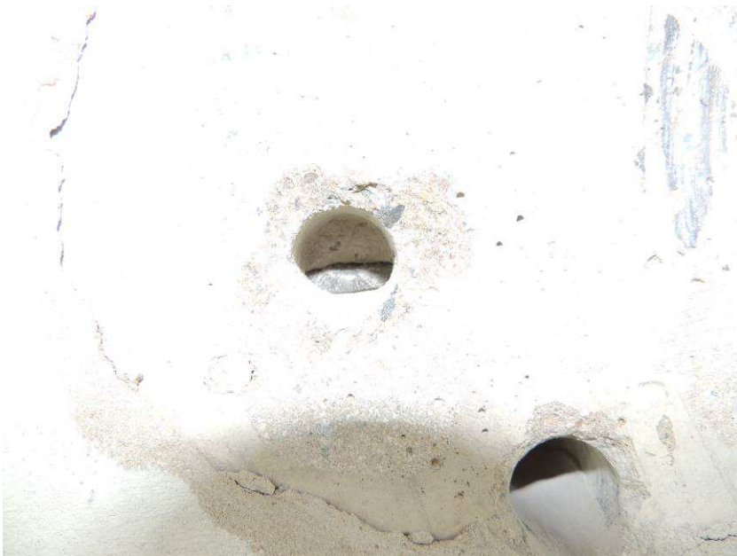
Sonda k předpínací výztuži nosníku N11 z boku
